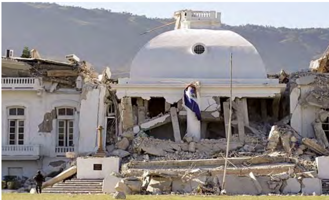
Figure1 : Palais national effondré
