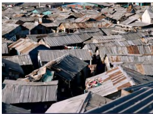
Image 5: toiture en tôle des habitats en 1990
