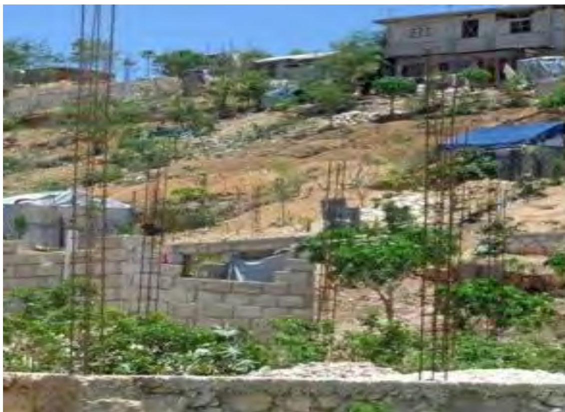
Figure 73 : Début de construction d'un habitat permanent
